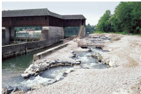
Obrázok 4: Príklad biokoridoru – zabezpečenie priechodnosti rieky pre ryby
